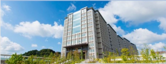
SUURI-COOL Kyushu (Ito, West no.1 bldg., 7F)
