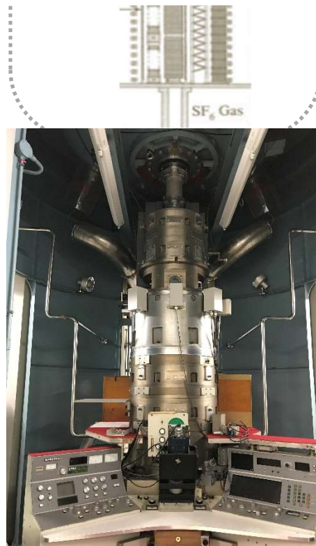
HV-2000の写真 (1970年に建設)
